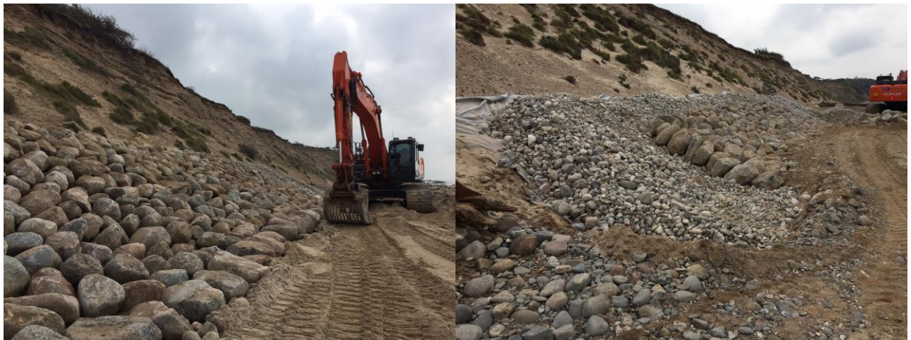
Figur 4-4 Eksempel fra COWI-projekt udført med 300-1000 kg marksten i et lag (anlæg a=1.75 ) udlagt på ral.
