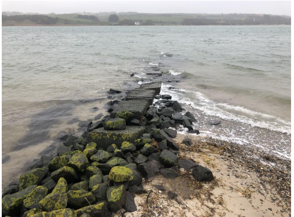
Foto 6 Høfde 3 – bestående af 10-50 kg sten og høfdeblokke
