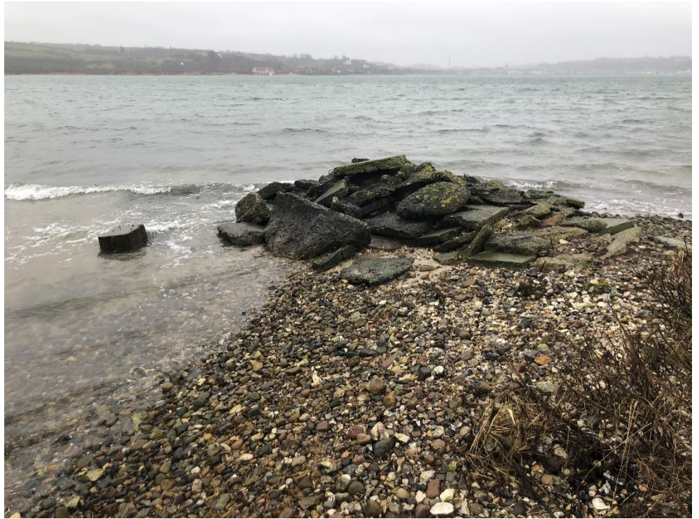
Foto 2 Høfde 2 – bestående af betonbrokker
